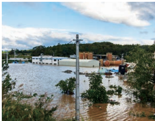
水害直後の富久山工場（2019年10月13日撮影）
